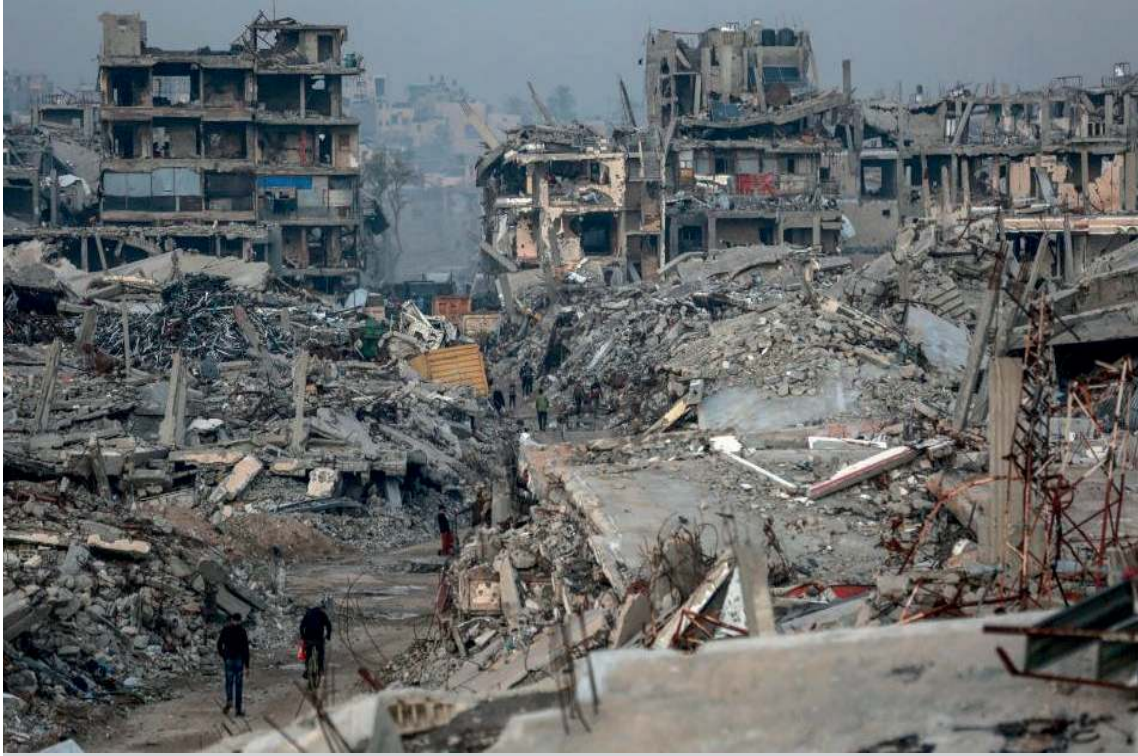
Halk, Gazze şehrinin güneydoğusundaki Zeitoun mahallesinde enkaz arasında yürüyor, 27 Kasım 2025 (Fotoğraf: China Daily, 2025)
